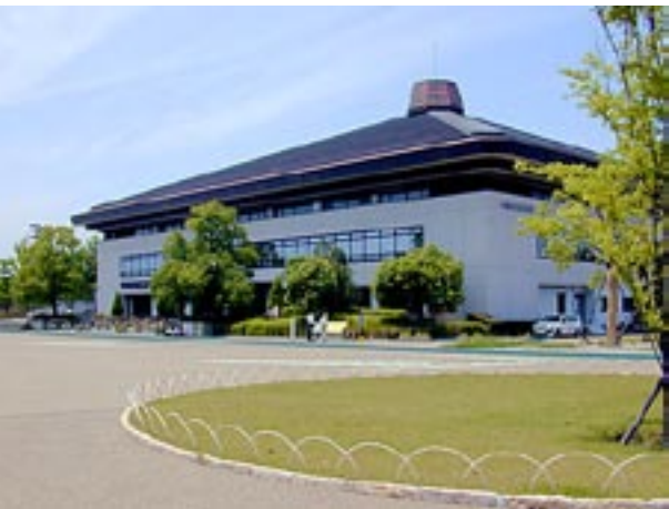
八幡市民スポーツ公園体育館、広大な敷地に球技場やテニスコートなどがある
