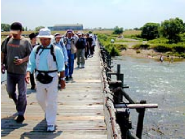
増水して水に浸かると橋板が自然に浮かび、八つに分割してワイヤーで繋がれた橋板が流れる「流れ橋」
