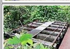
線路跡が残る、枕木には両端に鉄の輪が打ち込んである
