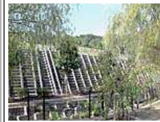
地下水を集めて抜くなどの対策工 事をした斜面、虫をよみがえらせ てと小川がある
