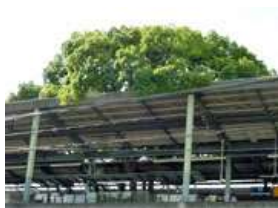
楠の木が突き抜ける萱島駅
