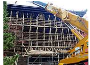
三門瓦の落下防止工事中
