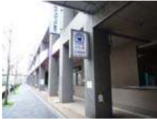
京都地下東西線醍醐駅
