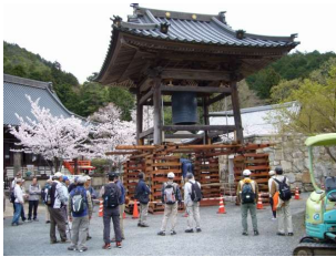
本圀寺 鐘楼移設工事中
