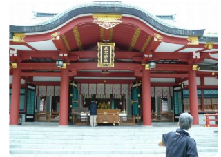
ゴールの西宮神社本殿
