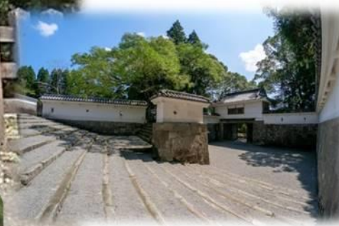
大手櫓形と石段・土塀の全景。
