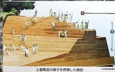
土塁築造の様子を再現した模型
