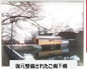
復元整備されたご廊下橋
