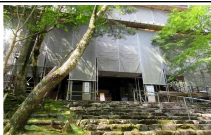
神護寺 楼門(改修工事中)
