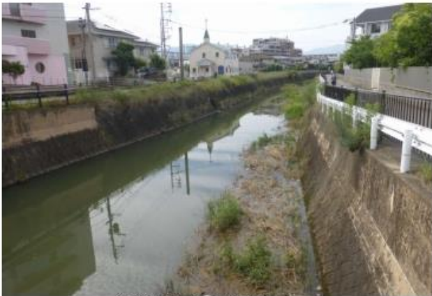
倉道橋より上流を見る
