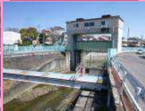
寝屋川浄化ポンプ場
