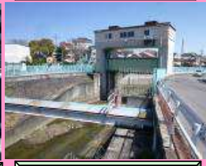
寝屋川浄化ポンプ場
