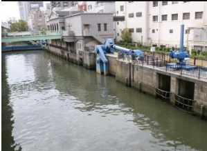
東横堀川水門
